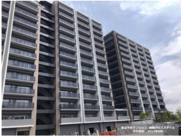
実証 マンションプライムメゾン 照葉クロススタイル
