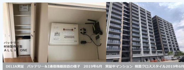
DELIA実証 バッテリー&IoT通信機器設置の様子 2019年6月 実証マンション 高家クロススタイル2019年6月
