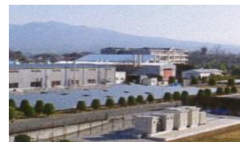
太陽光発電/パワコン
