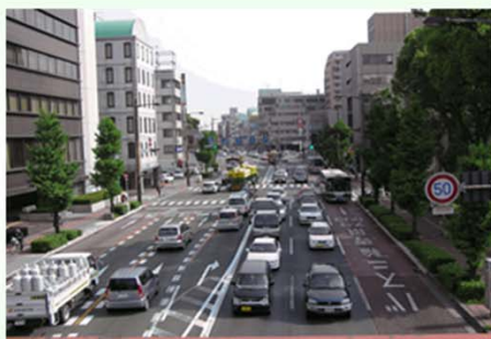
▲バス専用レーン(国道3号)
